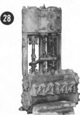
T-2 TANKER BILGE, BALLAST AND FIRE PUMP
